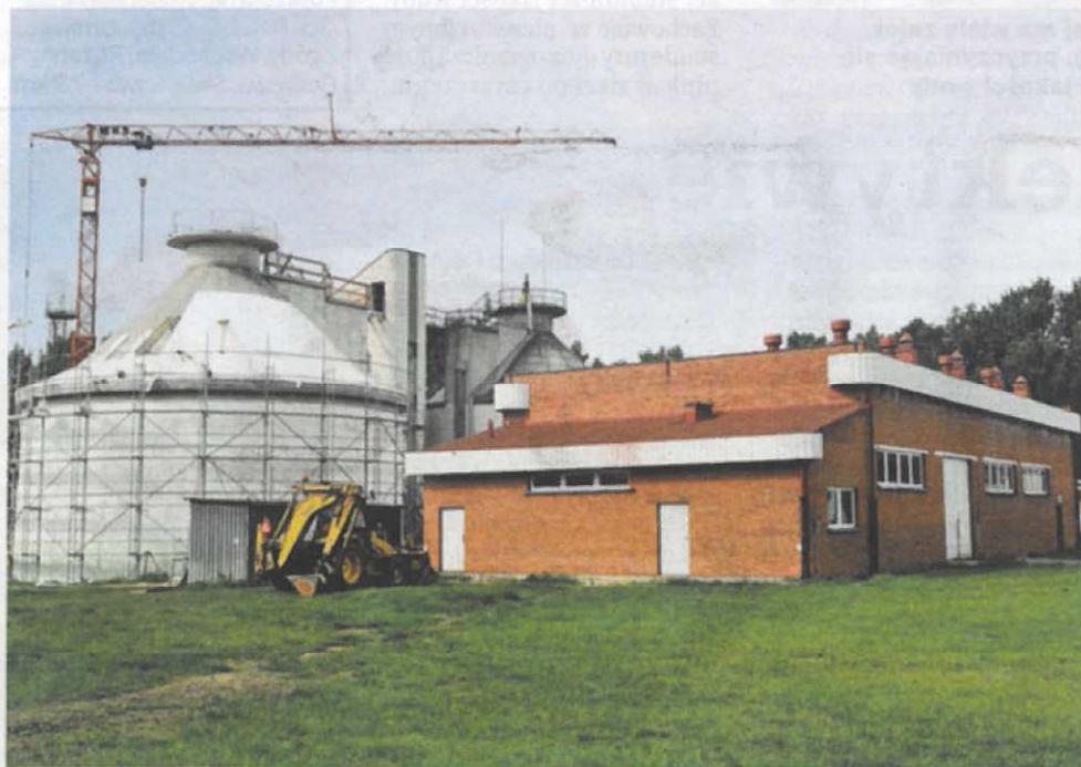
Nowoczesna komora fermentacyjna w trakcie realizacji
